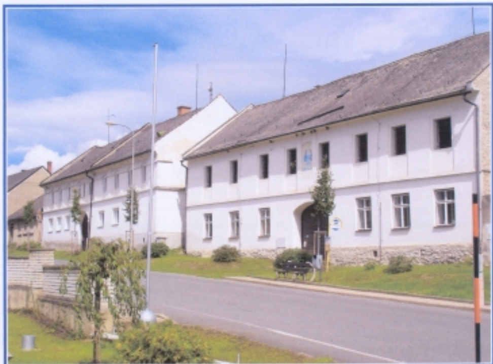
Obec Třeština - usedlost č.p. 7 a usedlost č.p. 8
