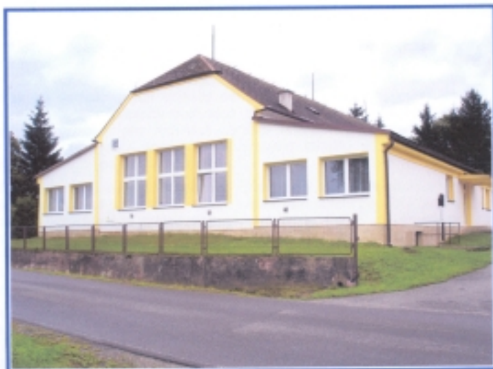
Oprava kulturního domu Třeština
