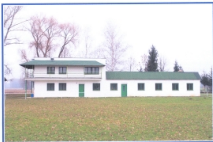
Oprava kabin pro sportovce areál sportoviště Třeština
